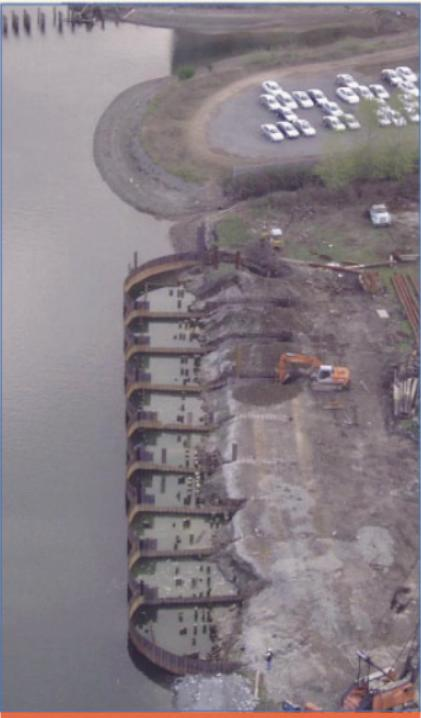
Рис. 1. Строительство шпунтового ограждения American Construction.
